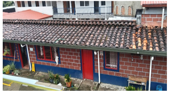
Reparación hecha del tejado del Colegio Beato Domingo
